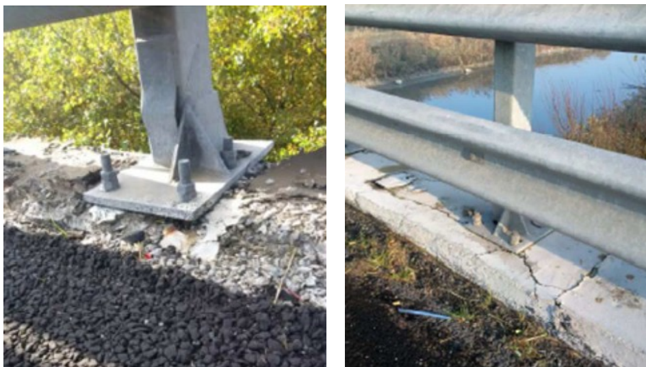
Figura 4 – Esempi di non integrità dei supporti delle barriere di sicurezza.
